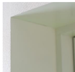
Væv/filt opsættes og skæres helt til den færdigbehandlede lysningskant og væggen males.
