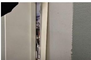
Monter armeringsbånd, i våd spartelmasse , mellem mur og hele Unique listen med overlap i hjørner.
