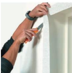
Væv/filt opsættes og skæres helt til den færdigbehandlede lysningskant og væggen males.
