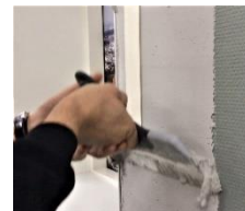
Skjul Unique listen med spartelmasse, der trækkes helt til spartelkant.
