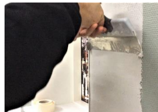
Påfør 1 mm spartelmasse
