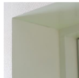
Væv/filt opsættes og skæres helt til den færdigbehandlede lysningskant og væggen males.
